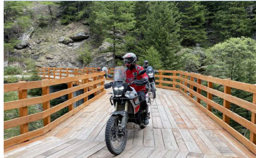
Brücke 1: Befahrung auf eigene Gefahr, aber nicht wegen des Brückenzustands
